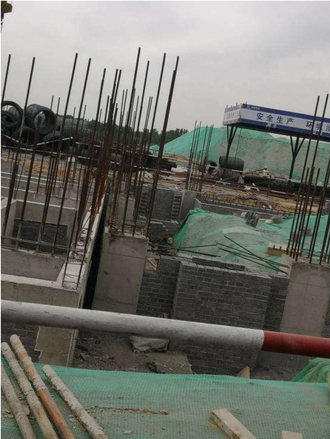
然后我们又去了一个正在浇筑的地基，图片最右侧的管是混凝土输送泵的管，哪里需要混凝土，导管就向哪里移。木条是用来防止刚刚注入的混凝土泄出的。白色的海绵条则是为了保证钢板间的严密性。而且从途中可以看到，剪力柱所竖的钢筋与墙体之间并不是平行的，据负责人说，墙面不齐是为了浇筑时墙和钢
