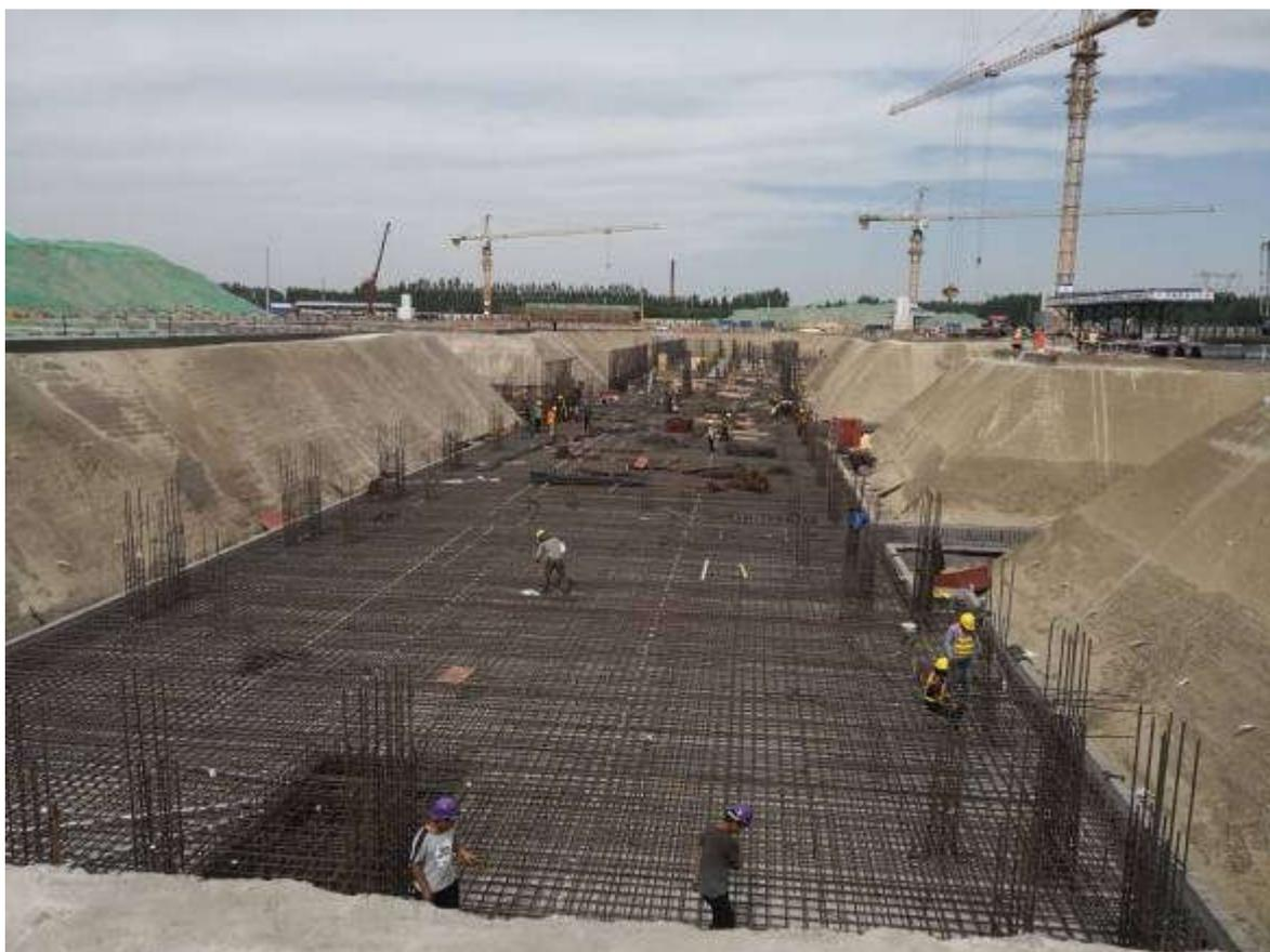
下面两图是一个砌好的地基，但是还没有浇筑混凝土，可以看到，（图一）有一道明显没有砌的钢筋，这是后浇带，因为混凝土具有膨胀性，在打地基的时候留出后浇带，注完混凝土以后根据混凝土型号静置，等混凝土膨胀完以后再填后浇带，根据膨胀性留出伸缩缝（图二），这样安全性就有了很大的保证，可以说，考虑的是面面俱到。
